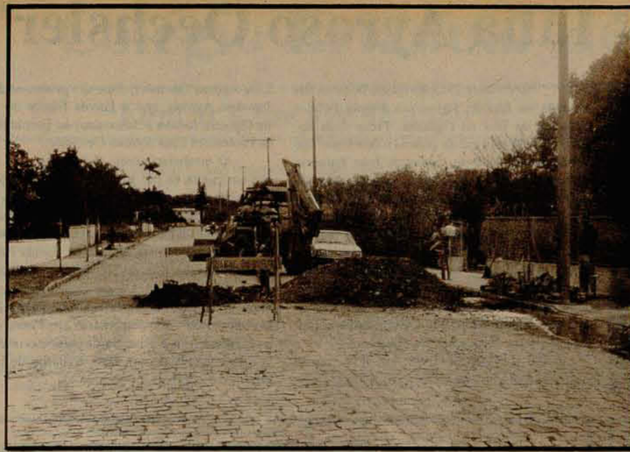
O flagrante mostra uma equipe de trabalho do SAMAE executando melhoramentos na rua 25 de Julho, para os serviços de esgotos para a população local. É a municipalidade atenta aos reclamos da comunidade.
