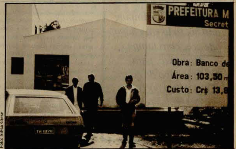
Obra do Banco de Sangue em fase de conclusão
