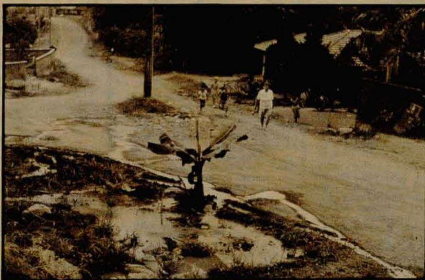
Esgoto transborda e cruza o leito da rua
