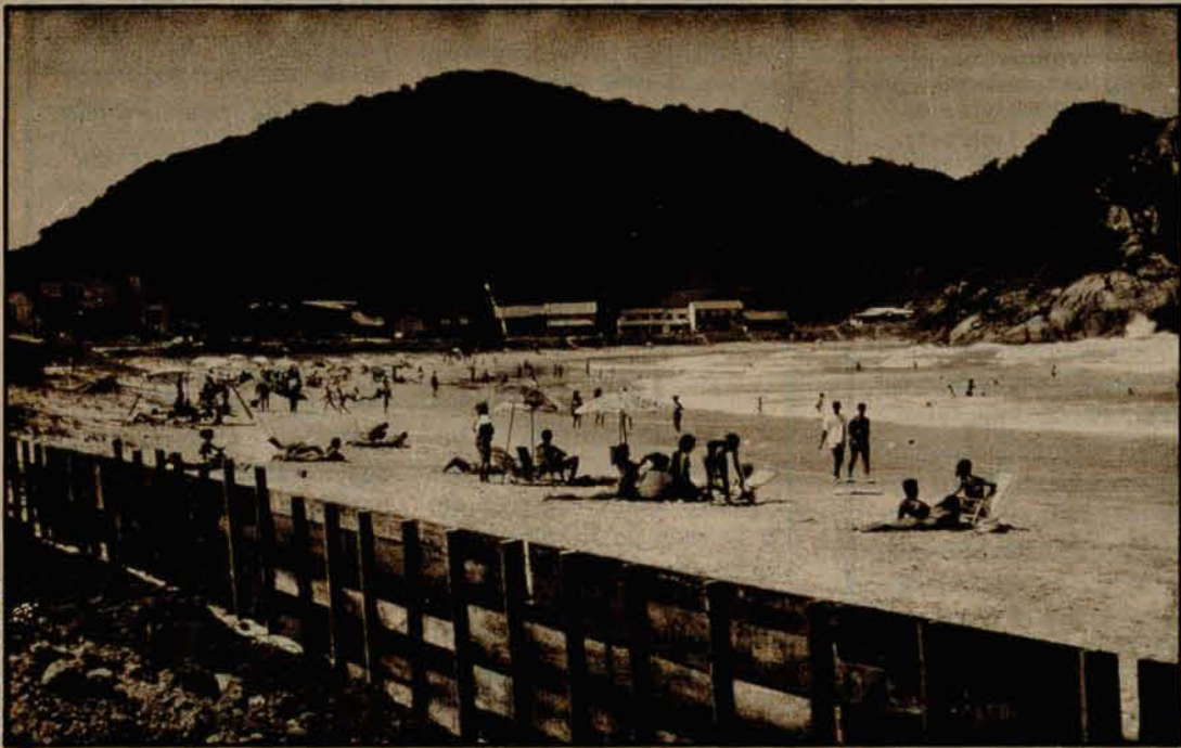
Na Prainha, obra está na fase inicial.
