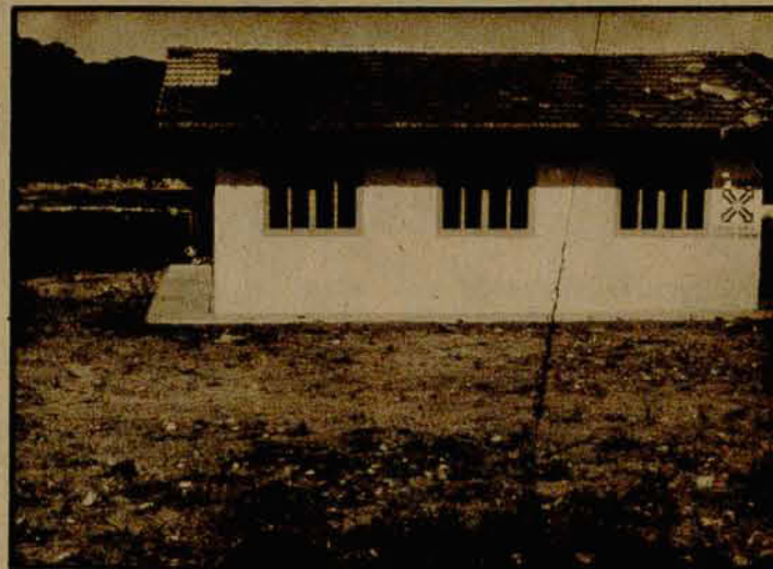
Construção de postos de saúde como este atendem o interior.
