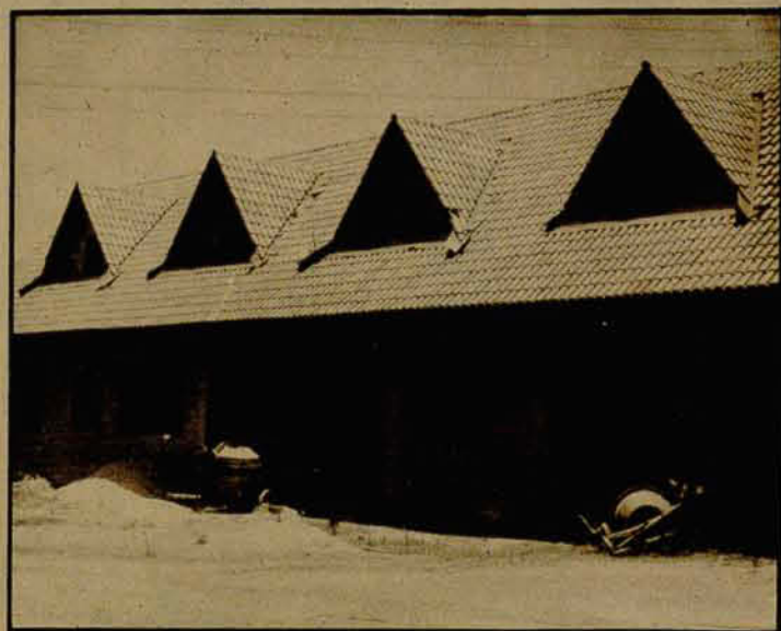
Construção da nova prefeitura em ritmo acelerado
