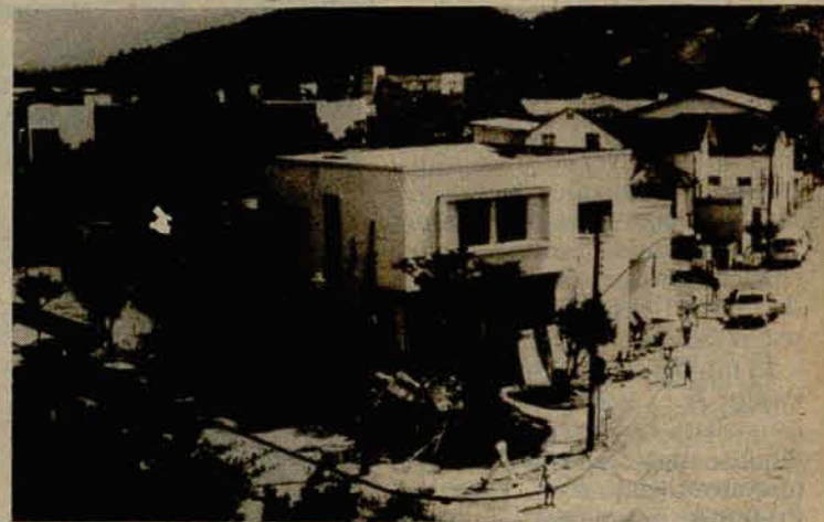
Reforma feita no antigo prédio dos Correios melhora atendimento
