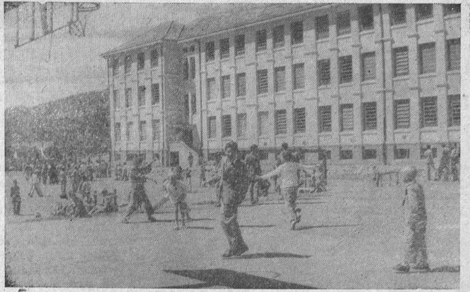
Vista parcial da fachada do Ginásio São Luís
