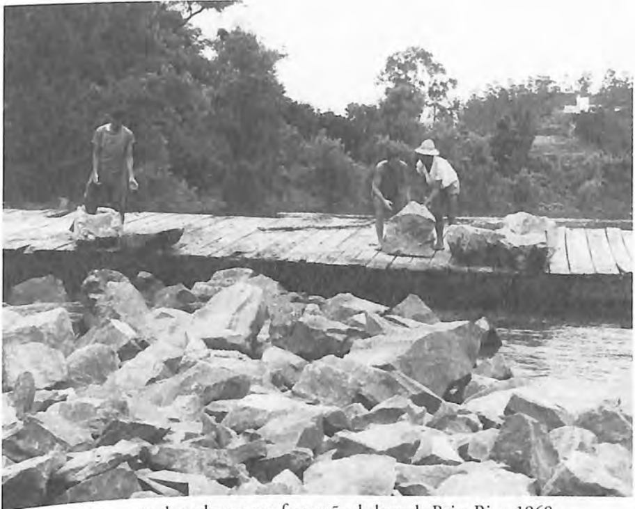
Colocação de pedras para a formação da base da Beira Rio - 1968.
