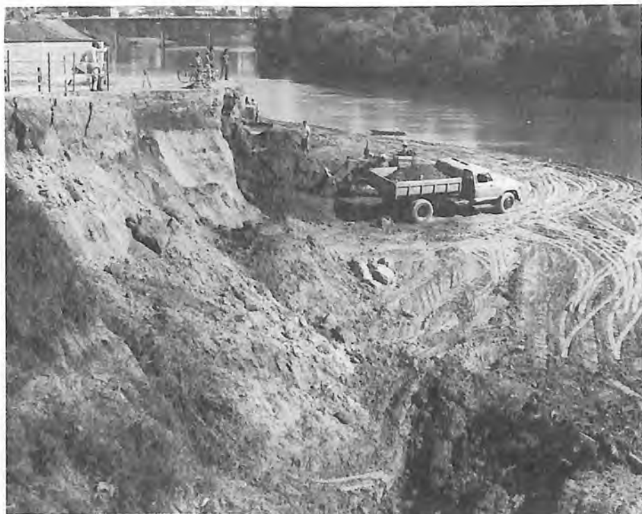
Trabalhos de estrutura e base para a construção da Beira Rio.
