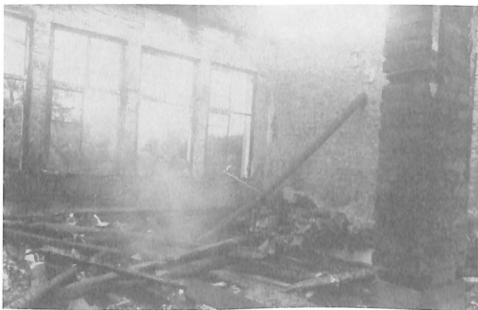
Fig. 3 - Vestígios do incêndio de 8 de novembro de 1958. Interior do Arquivo Municipal de Blumenau. Acervo A.H.J.F.S.
