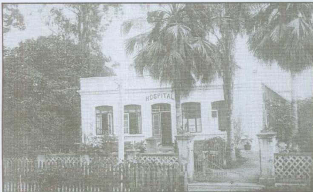
Hospital Santo Antônio na Rua Itajaí, após 1874
