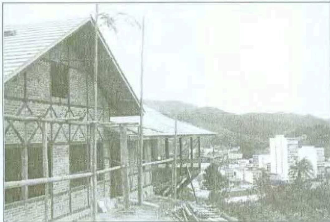
Construção do Restaurante Frohsinn, no “Morro do Aipim”, 1968
