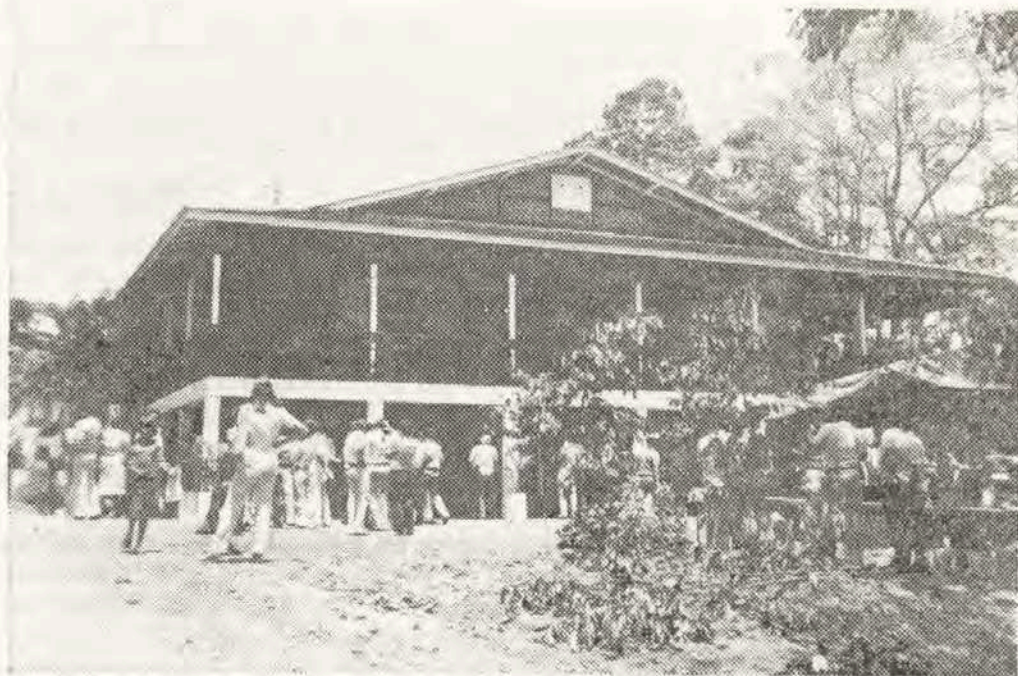
A bela e confortável sede da ASPMB, construída em estilo típico europeu e inaugurada dia 30/10.
