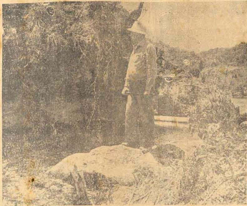
O cel. Graciliano Negreiros no local onde será construída a barragem do 8º salto.
