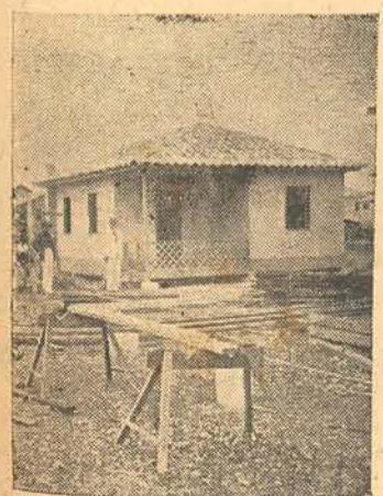
UMA CASA DE OPERARIO DA C. B. C. A.
