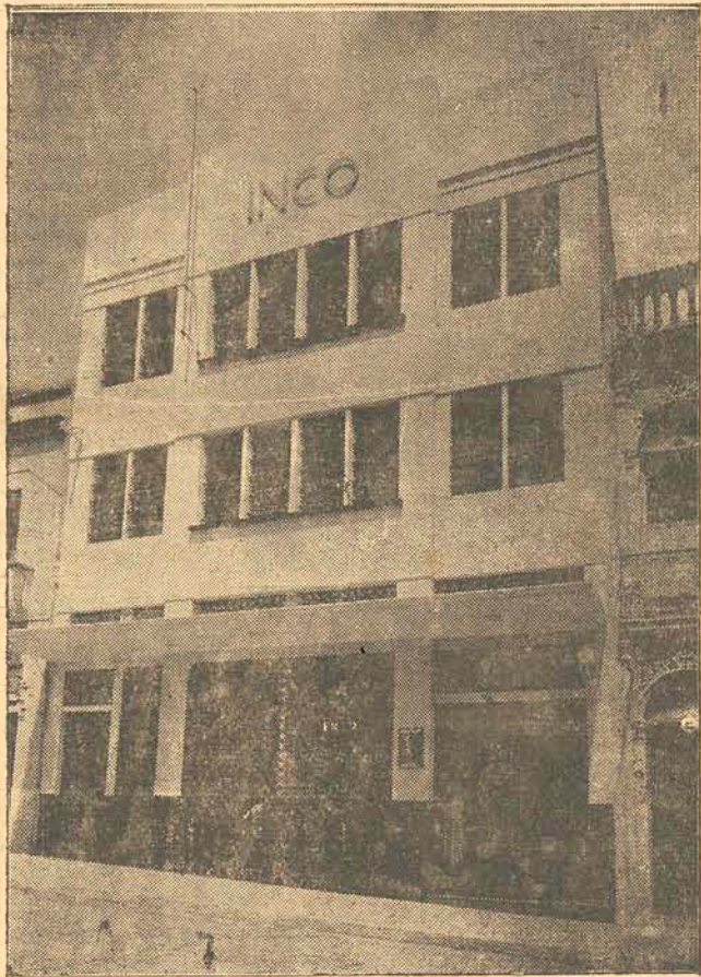
Prédio onde está instalada a sede da Companhia
