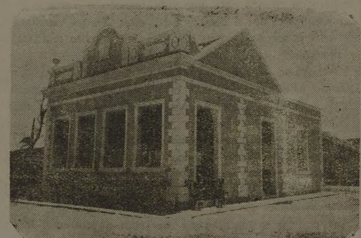
Escola rural de Roçado em São José
