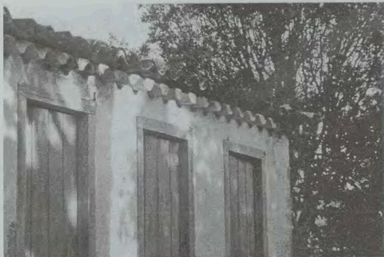
*Foto 03 - Detalhe de uma beira ceveira. Trata-se de um rebordo desenhado por baixo e em sentido de arcos contrários às telhas do beiral. Talvez tenha surgido não só como adorno, mas também para dar mais resistência e apoio às largas beiradas do telhado. Como engorda o beiral, tenha sugerido a aplicação do verbo cevar, engordar, alimentar bem os animais, para denominá-la. (Foto de Nereu do Vale Pereira)*
