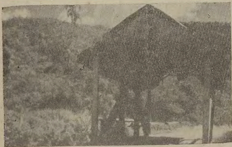
Fig. 9 Ponte sôbre o rio Sorocaba (Município de Biguaçu)
